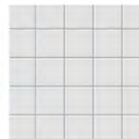
Azulejos y Juntas
